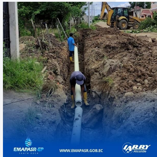
CONSTRUCCIÓN RED TERCIARIA CDLA. LAS PALMERAS
